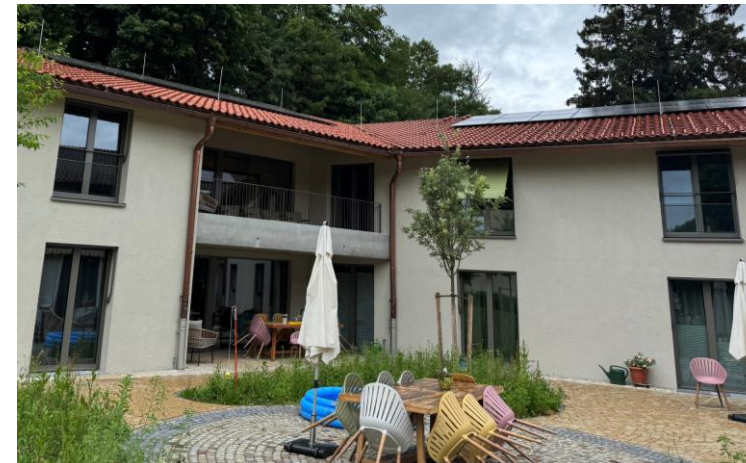
PV-Anlage auf dem Dach des Wohnheim 1.
